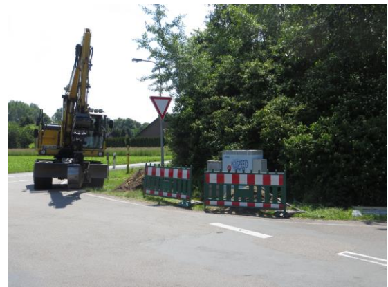
Erdarbeiten am KVZ Ostenwalder Str. für den Herthasee
