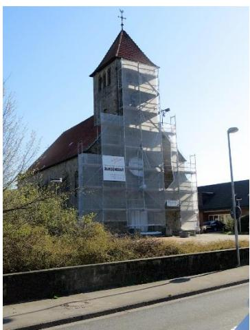
Seit Anfang der Woche ist der Kirchturm der Kirche St. Marien eingerüstet. Die Fugen der Sandsteinwände sind dringend saniert. Den Auftrag führt die Fa. Paetzke aus. Mit Elektrohämern werden derzeit die Fugen ausgestemmt. Zunächst war die Maßnahme nur für die Wetterseite am Turm vorgesehen. Jetzt, wo das Gerüst steht, zeigt sich bei genauerem Hinsehen jedoch auch ein Bedarf an den Seitenwänden und auch an der Rückseite.
